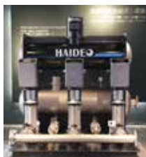
▲ 双罐式无负压供水设备
